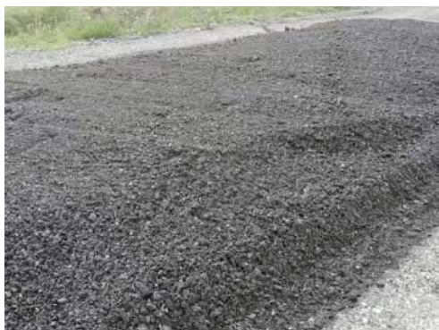
Asfalto rigenerato, non ancora compattato, grazie alla miscelazione con additivo
